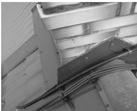
Rys. 4. Przykład a) nieprawidłowego, bez mocowania prowadzenia przewodów na dachu budynku, b) rozwiązanie prawidłowe
